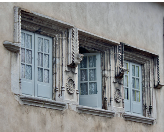
Fenêtres de la maison Bayo, XVI e siècle.
